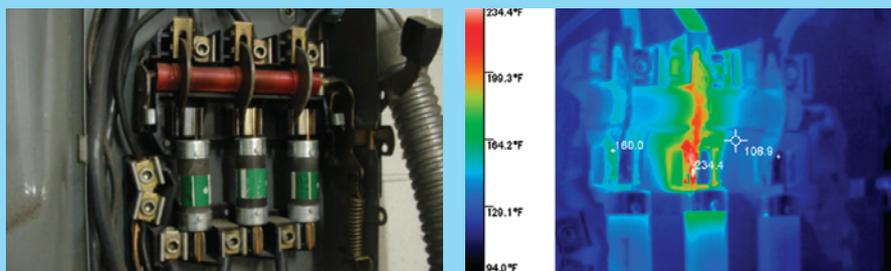
Les mesures de température montrent que les connexions sur les phases A et B de ce tableau électrique sont chaudes, laissant supposer une charge déséquilibrée.
